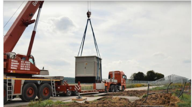
Abbildung 38: Anlieferung einer Übergabestation per Schwertransport auf Bodenschutzplatten (© JUWI GmbH)
