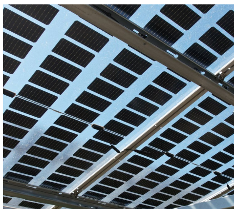
Installation von teilweise lichtdurchlässigen Paneelen („verbesserte Zebromodule“)
